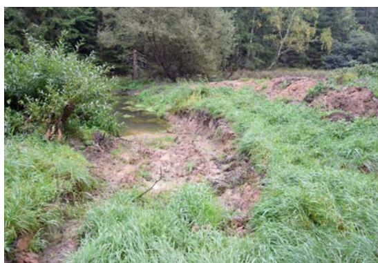
Bývalý rybník na ZSV Bohdalůvka poškozený bagrováním. (Foto: Jakub Novák, 2021)
