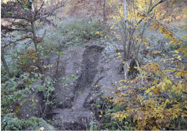
Obr. 9-5: Hráz rybníka v jižním údolí hradu Vildenberka s viditelnými pozůstatky realizovaného sondážního průzkumu.
