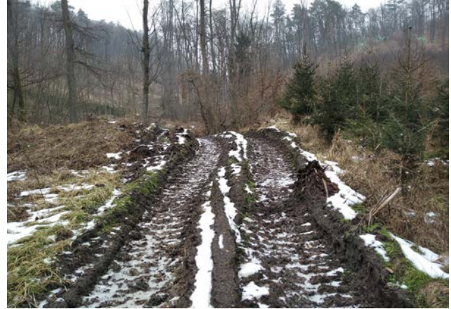
Obr. 9-6: Lesní komunikací porušená hráze rybníka v západním údolí hradu Vildenberk.
